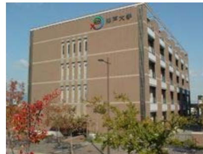
(神戸ポートアイランド地区)
